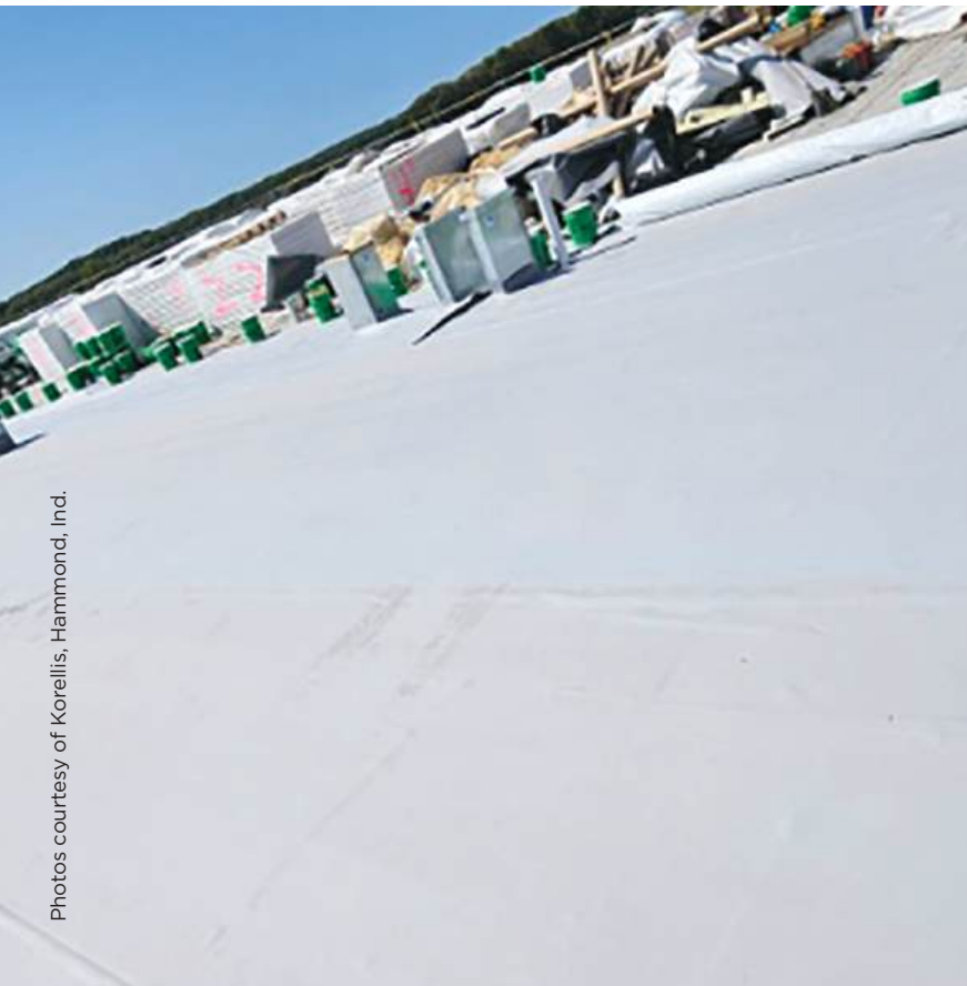
New TPO membrane
